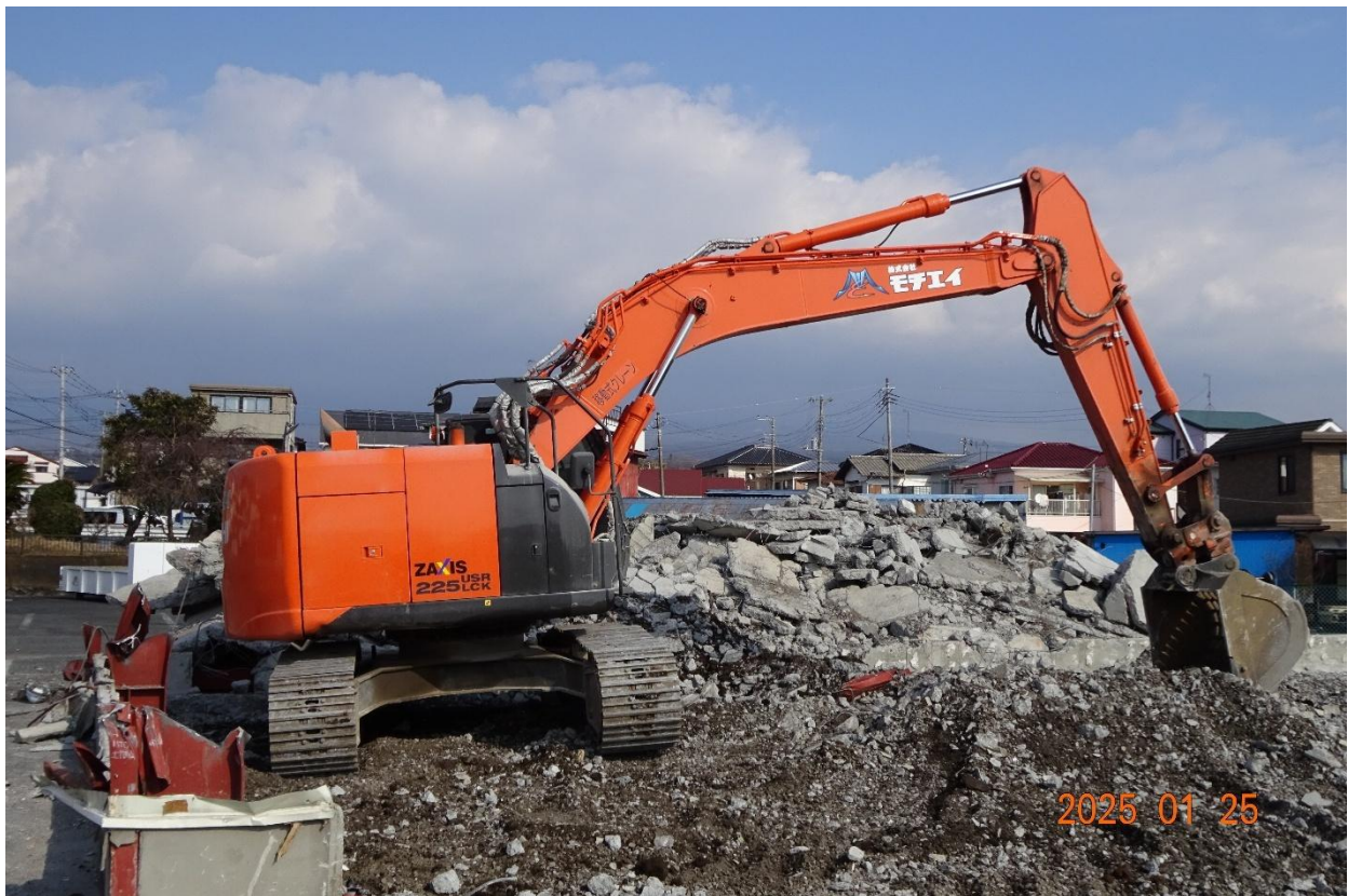
工事現場の大型パワーショベル
