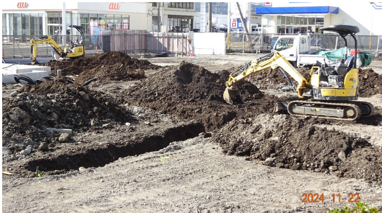
富士宮市内、車道沿いの建築工事現場の小型パワーショベル
